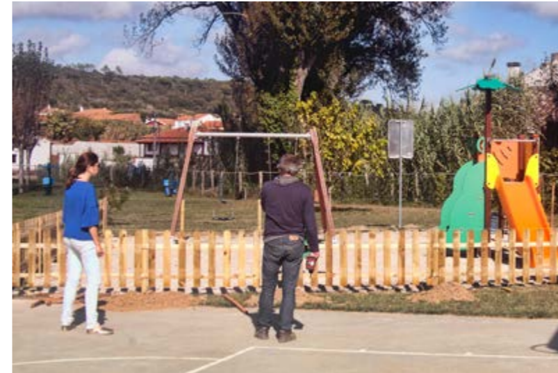
Colocação de Cerca de Protecção no Parque Infantil
